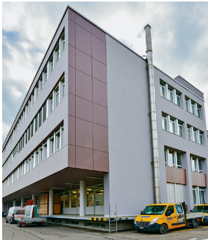
Sanierung GWH Stationsstrasse 12/14, Liebefeld
