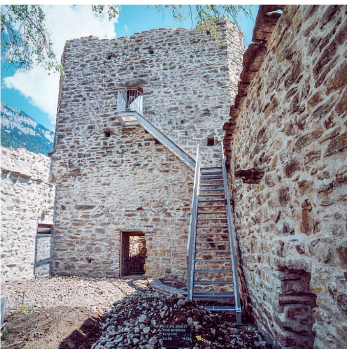
Burghof der Ruine Ringgenberg mit Blick auf die Fassade des Ostturms
