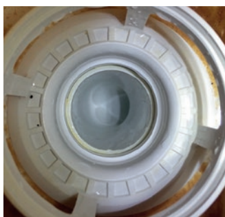
Entkalktes Spülrohr nach Service
