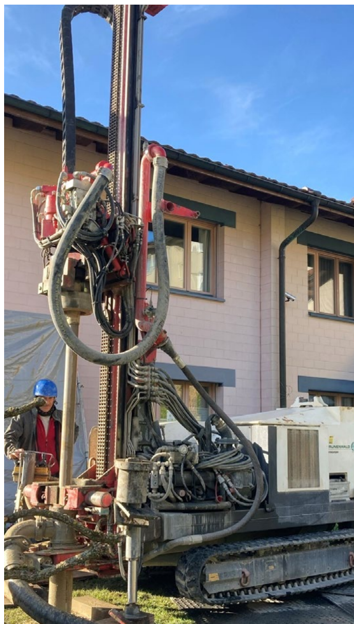
Kostengünstige Erdwärmesonden mit dem kleinsten Bohrergerät der Schweiz.
