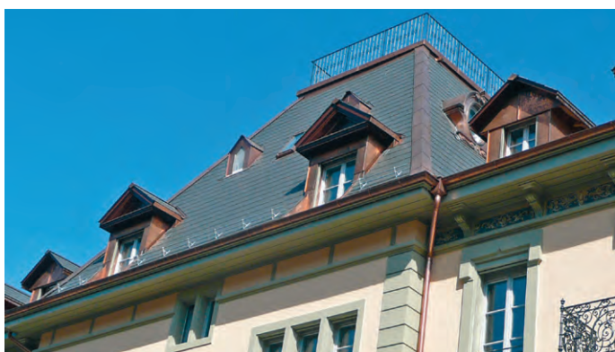
Restaurierte Fassade mit freigelegter Malerei unter dem Vordach.
