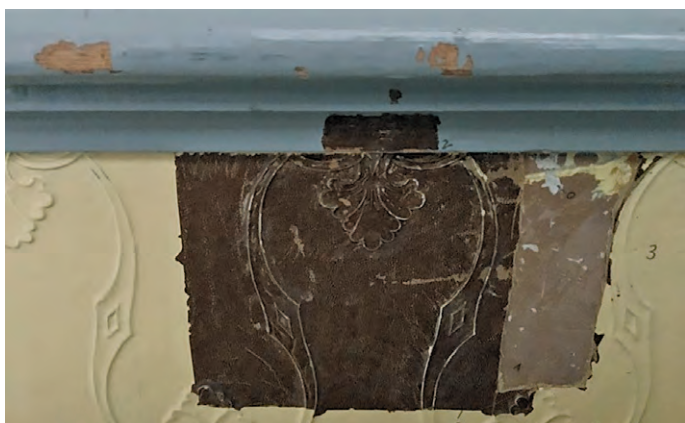
Schichtuntersuchung zur Bestimmung des Farbkonzepts.
